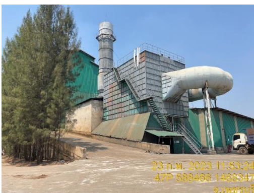
รูปที่ 2 ระบบดักฝุ่นแบบถุงกรอง
