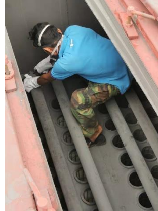
รูปที่ 7 การดำเนินการเปลี่ยนถลุงครั้งล่าสุด
